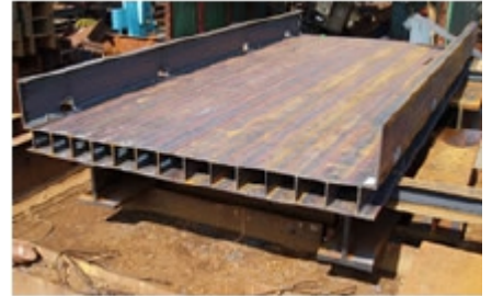
簡易工事桁製作
