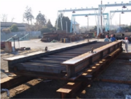
橋梁工事桁製作・組立
