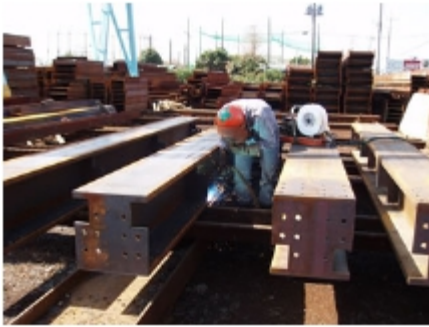
桁スティフナ溶接
